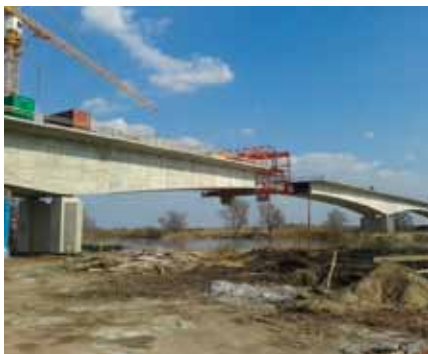
Fot 12. Most Wolności w ciągu Obwodnicy Aglomeracji Wrocławskiej nad rzeką Odrą w Brzegu Dolnym.
