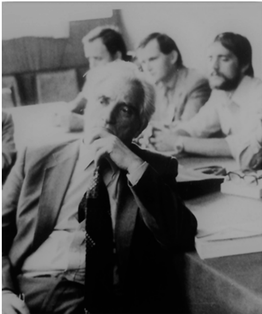
Prof. Mieczysław Rybak w czasie obrad Międzynarodowej Konferencji Bezpieczeństwo Budowli Mostowych na Politechnice Wrocławskiej w 1982 roku (fot. Z archiwum A.W.)
