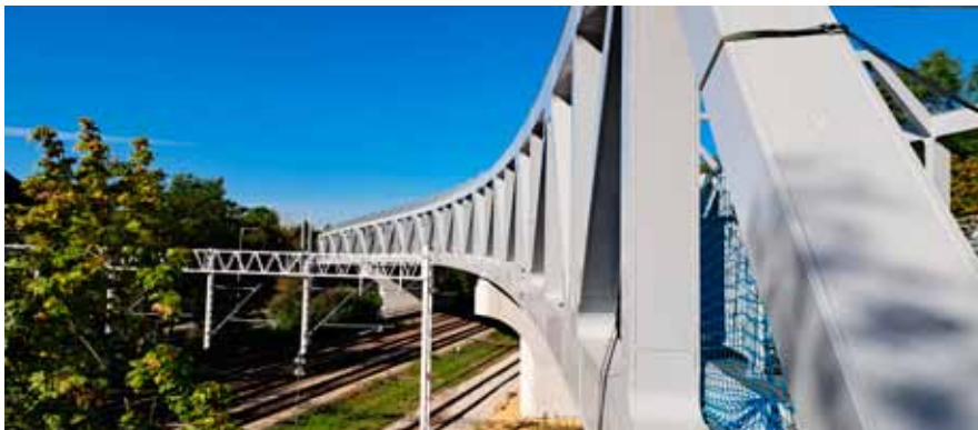
Widok z wiaduktu
