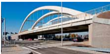
Fot 10. Wiadukt WD-3 w ciągu Śródmiejskiej Obwodnicy Wrocławia nad ul. Żmigrodzką.
