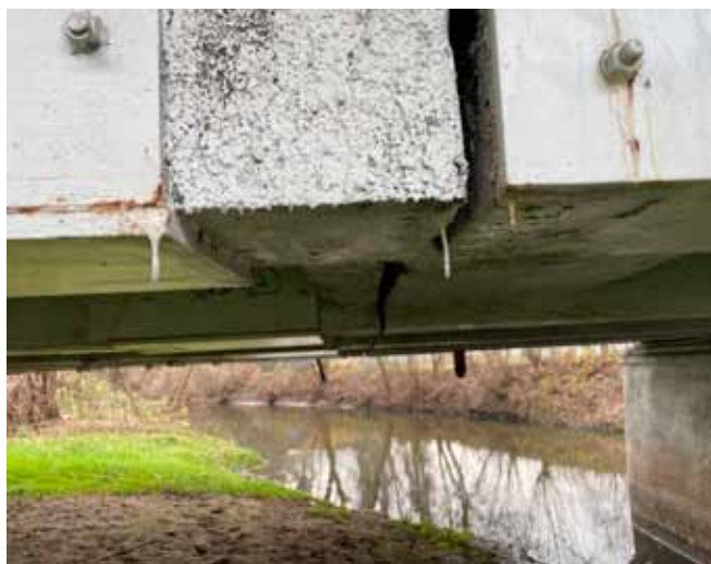
Widok na konstrukcję mostu podczas przeglądu (2021 r.)
