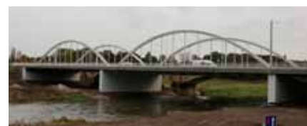
Fot 17. Most Bolesława Chrobrego Południowy we Wrocławiu na Kanale Powodziowym rzeki Odry.
