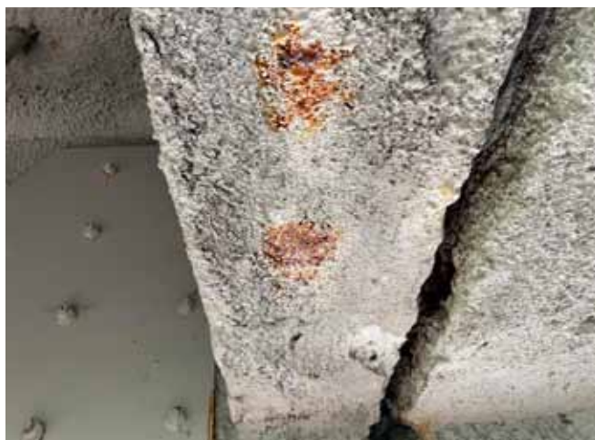
Rdzawe wykwyty z warstwy nowego torkretu (2022 r.)
