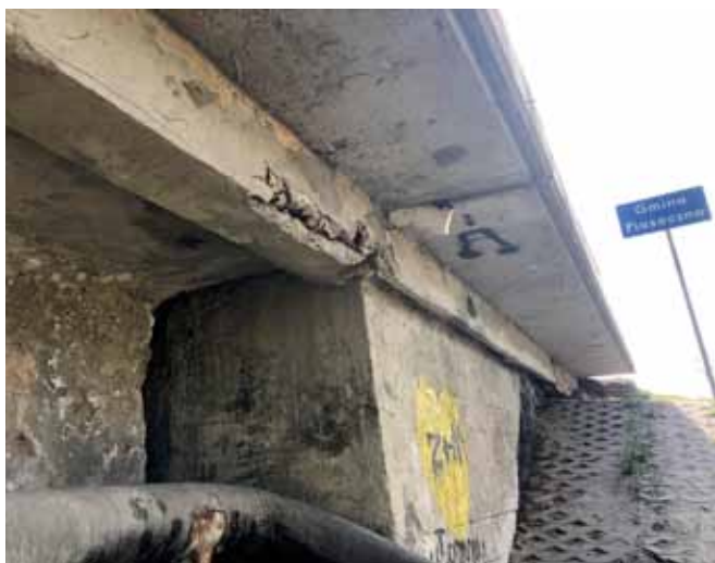
Widok na konstrukcję przed remontem (2019 r.)
