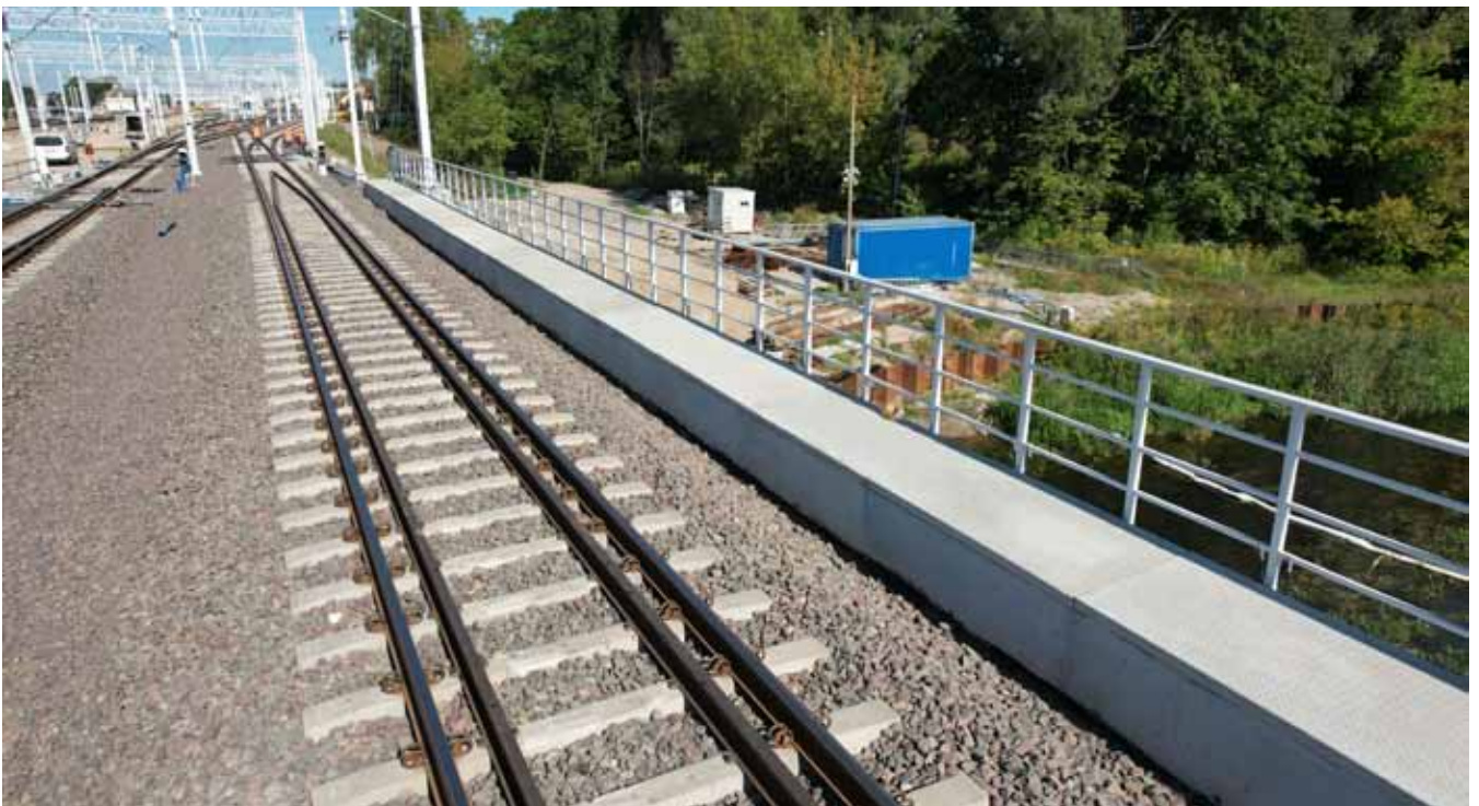
Linia kolejowa E75 w Ełku Most nad rzeką Ełk
