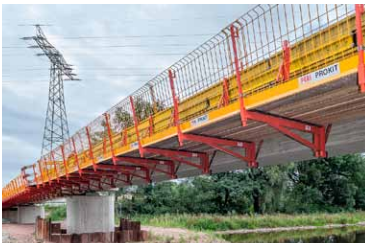
Fot. 2. Betonowanie kap chodnikowych w jednym etapie przy użyciu systemowych wsporników VGK.
