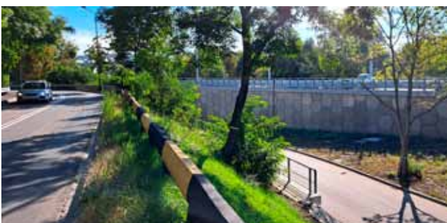
Widok od strony nasypu na ul. Strzegomskiej
