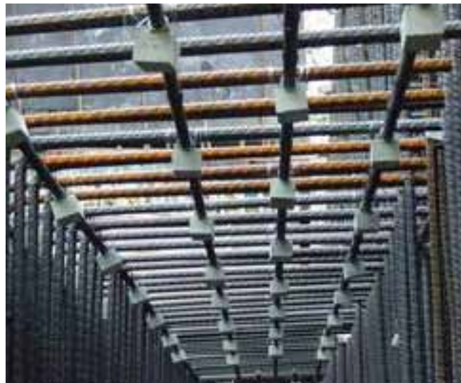
Zamontowane protektory cynkowe TopZinc (2015 r.)
