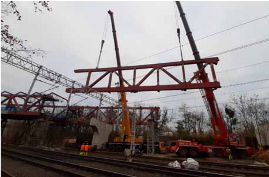
Montaż dźwigarów kratownicy
