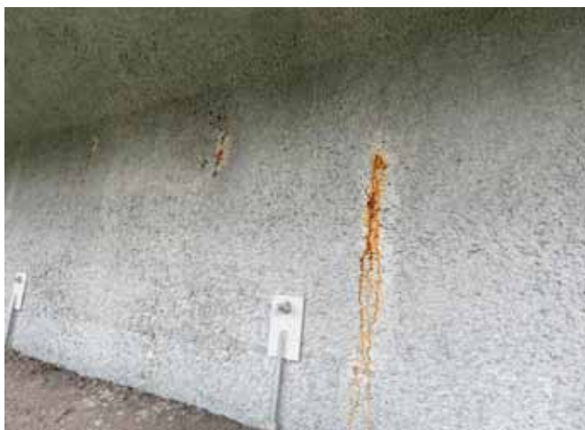
Rdzawe wykwyty z warstwy nowego torkretu (2022 r.)
