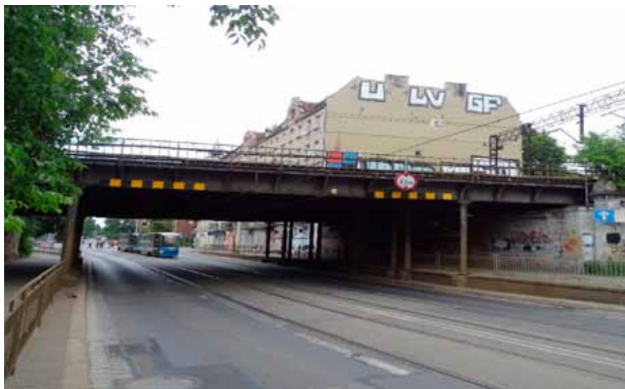
Fot. 7 Widok na wiadukt w km 160,876 linii kolejowej nr 143
