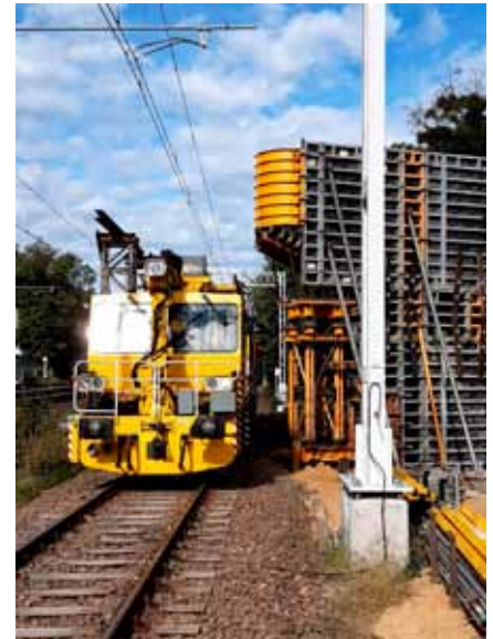
Linia kolejowa tuż przy podporze wiaduktu
