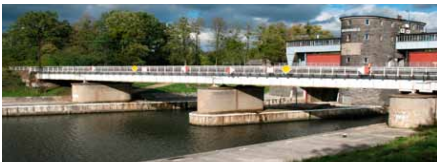
Fot. 9 Most w km 2,528 linii kolejowej nr 136 – stan przed przebudową
