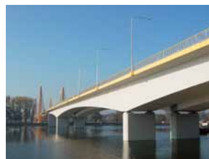
Fot. 5 Most Milenijny w ciągu Obwodnicy Śródmiejskiej w części trzyprzęsłowego mostu nawisowego nad zimowiskiem barek o długości 260 m.
