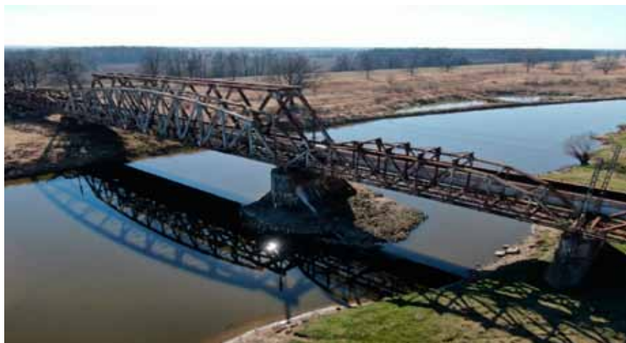
Fot. 1 Widok na przęsła nurtowe mostu w km 28,297 linii kolejowej nr 273
