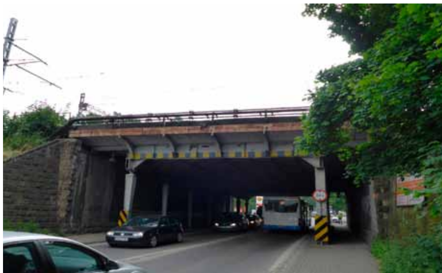
Fot. 2 Widok na wiadukt w km 0,295 linii kolejowej nr 173
