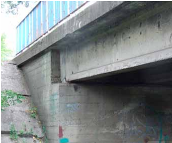
Widok na konstrukcję przed remontem (2014 r.)
