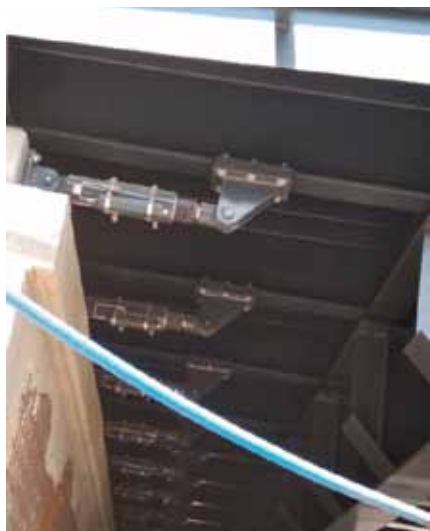
Fot. 6 Wiadukt w km 0,295 linii kolejowej nr 173 – tłumiki przekazujące siły wzdłużne na przyczółek
