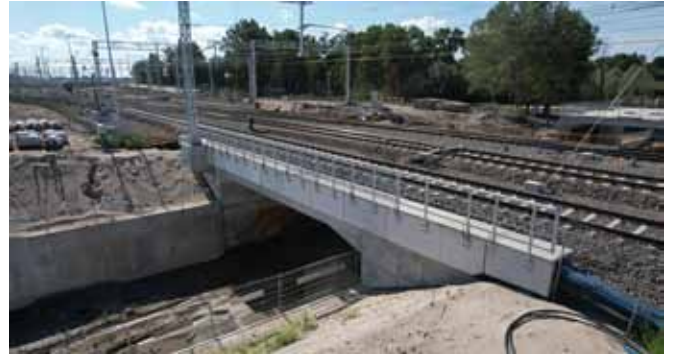
Linia kolejowa E75 w Ełku Wiadukt nad ul. Towarową
