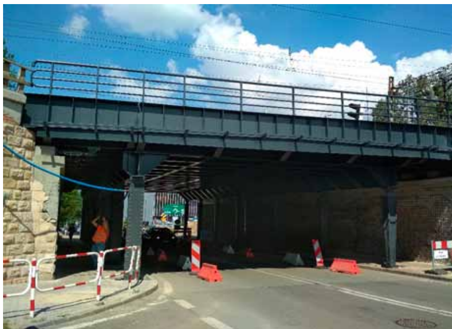
Fot. 5 Wiadukt w km 0,295 linii kolejowej nr 173 – widok w trakcie przebudowy
