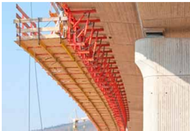
Fot. 1. Urządzenia przejezdne z konstrukcją dołem (po lewej) oraz konstrukcją górną (po prawej).
