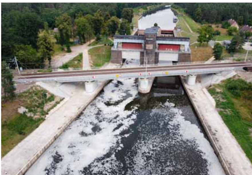
Fot. 11 Most w km 2,528 linii kolejowej nr 136 – stan po przebudowie (fot. Błażej Kozłowski)
