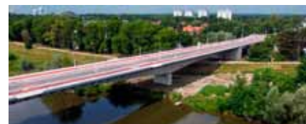
Fot 14. Most Olimpijski w ciągu Alei Wielkiej Wypsy na Odrze
