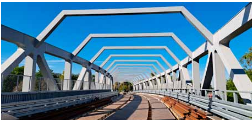
Jezdnia na wiadukcie
