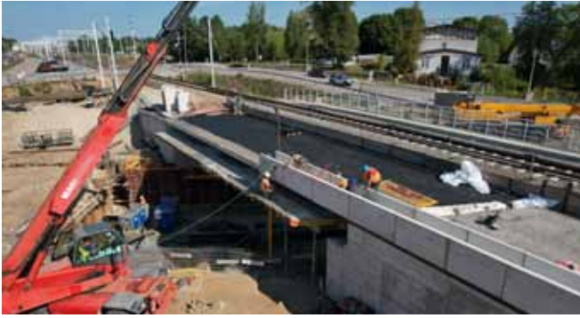
Linia kolejowa E75 w Ełku Wiadukt nad ul. Kolejową
