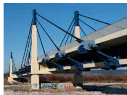
Fot. 7 Most św. Kingi przez Dunajec w ciągu połączenia drogi krajowej nr 87 z drogą powiatową Chelmiec - Gołkowice.
