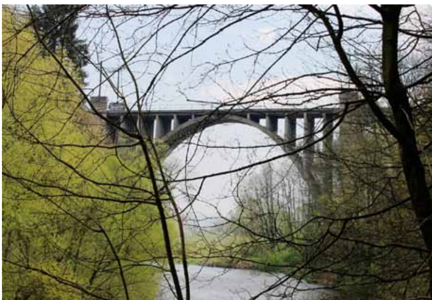
Fot. 8 Żelbetowy most kolejowy w Borowym Jarze (2020 rok) [źródło: archiwum autora]
