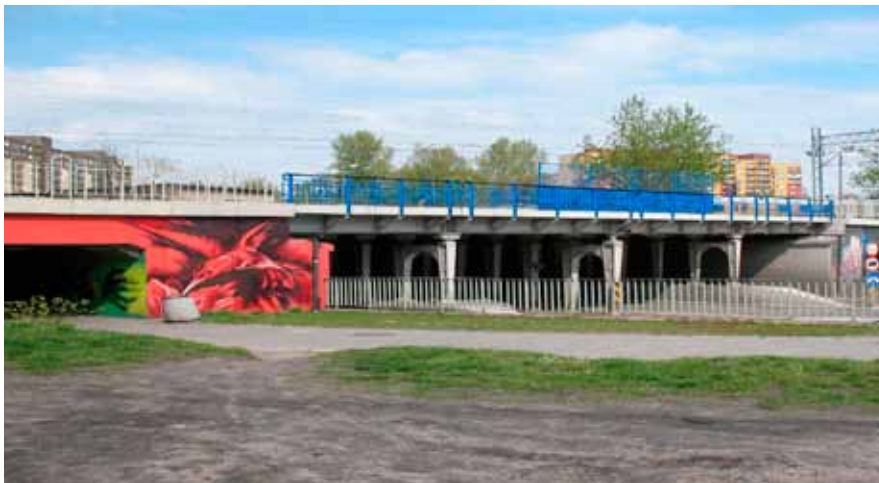
Fot. 8 Widok na wiadukt w km 309,941 linii kolejowej nr 1
