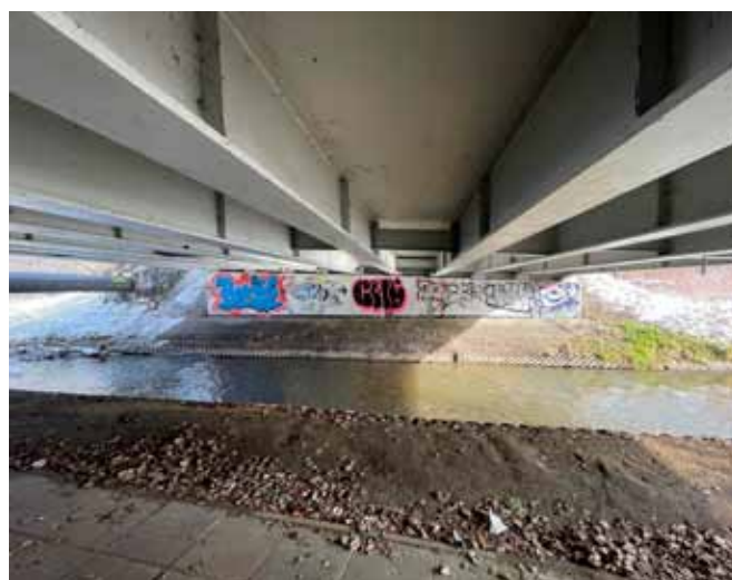
Widok na wiadukt podczas przeglądu (2022 r.)
