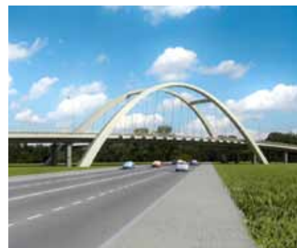
Fot 13. Wiadukt drogowy nad ulicą Trzebińską w ciągu obwodnicy północno-wschodniej Chrzanowa.
