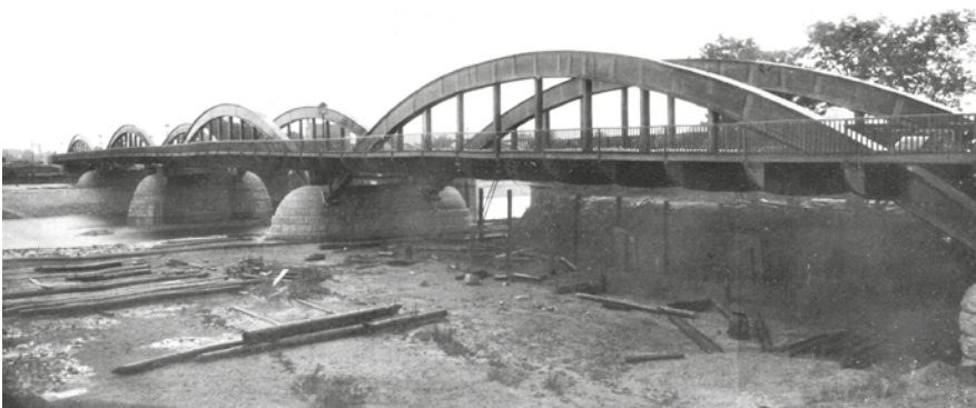
Rys. 6. Widok ogólny Rosenthaler Brücke pod koniec budowy [3]
