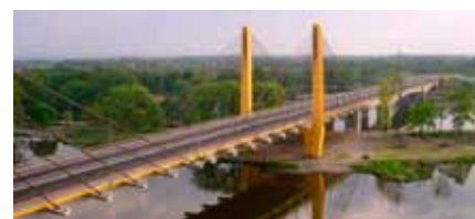
Fot. 4 Most Milenijny w ciągu Obwodnicy Śródmiejskiej w części o długości 290 m, podwieszony na dwóch pylonach o wysokości 50 m.
