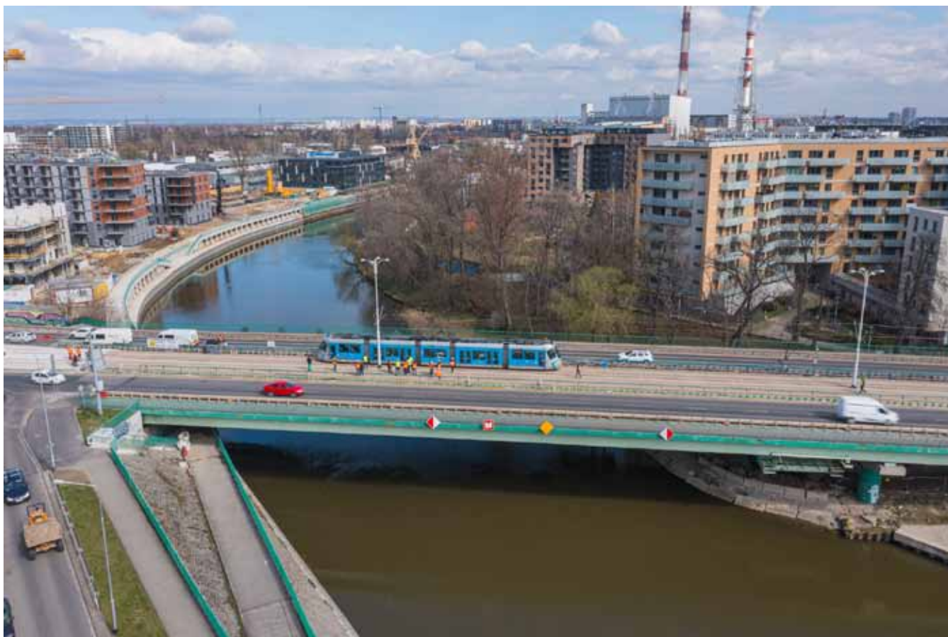
Fot. 16. Widok na most od strony górnej wody podczas procedury badań próbnego obciążenia (autor Foto wroclaw.pl/ jkrzeszowski)
