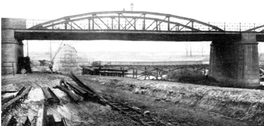
Rys. 1. Skrajne przęsło czteroprzęsłowego mostu Różaneckiego z 1873 r. [3]
