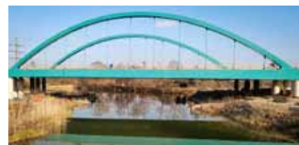
Fot 15. Most Na Wilczym Kącie w ciągu Alei Wielkiej Wypsy na Oławie
