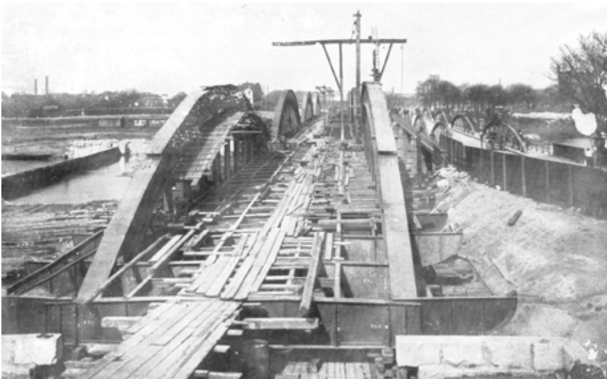
Rys. 5. Przebieg prac widziany od strony przyczółka lewobrzeżnego [3]
