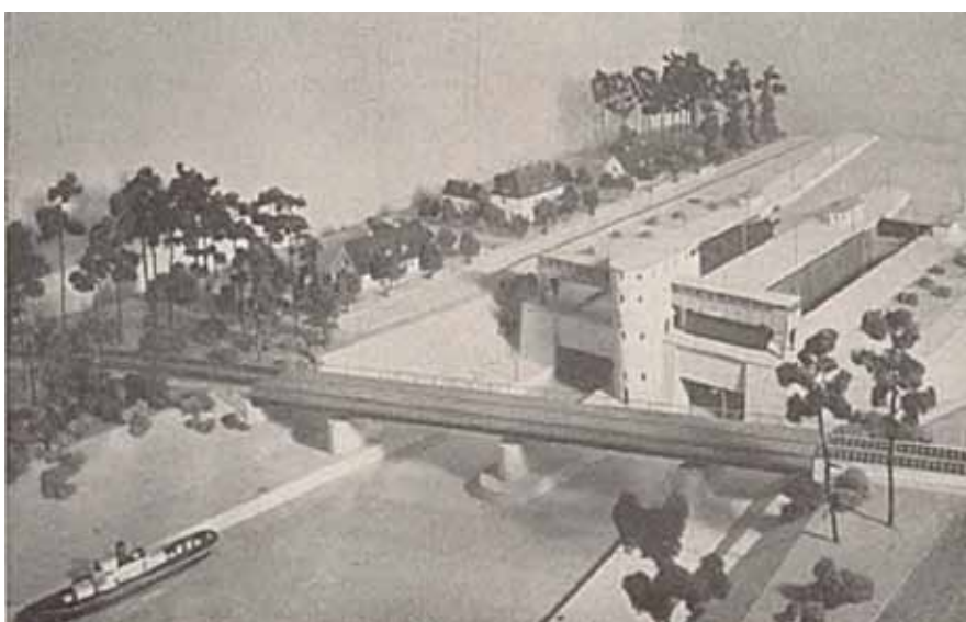
Fot. 10 Zdjęcie modelu śluzy Kłodnica wraz z widocznym mostem kolejowym, usytuowanym na awanporcie dolnym (Die Bautechnik, 17. Jahrgang, Heft 49, Berlin, 17 lutego 1939 r.)
