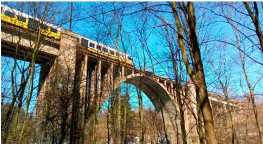
Fot. 6 – Żelbetowy most kolejowy w Borowym Jarze (2020 rok) [źródło: archiwum autora]
